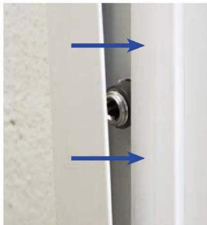
profilo a scatto per la copertura delle viti di fissaggio
